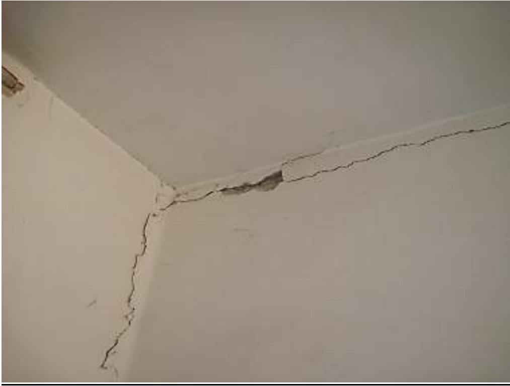
בתמונה למעלה מתוארים סדקי פינה אופייניים
